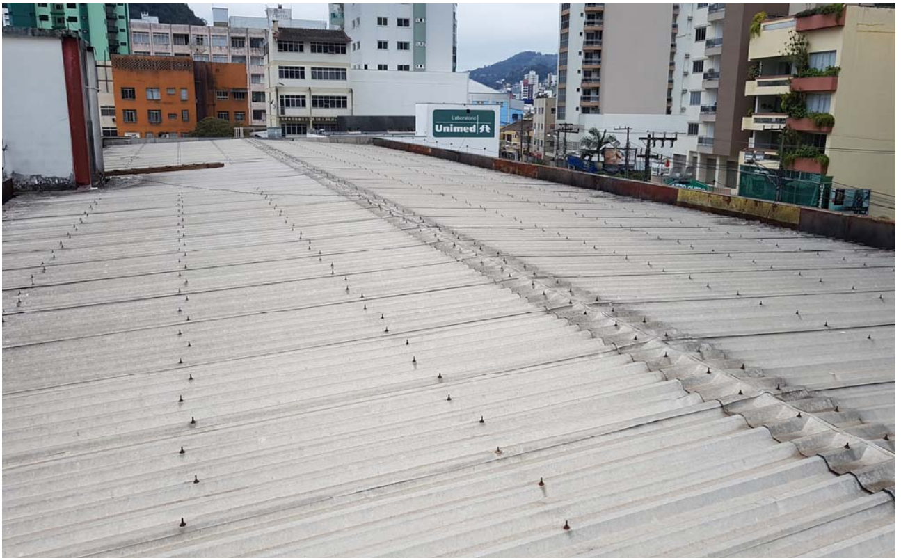
Aspecto geral do telhado existente
