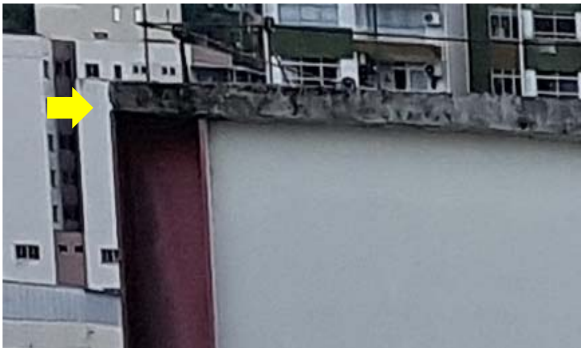
Laje de cobertura da torre das caixas d'água terminado no mesmo plano da face do pilar Lado da fachada posterior
