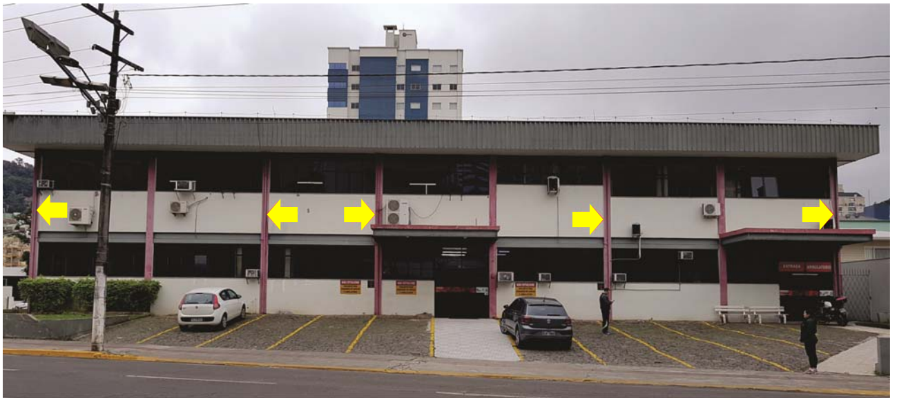
Posição dos condutores de águas pluviais na fachada anterior
