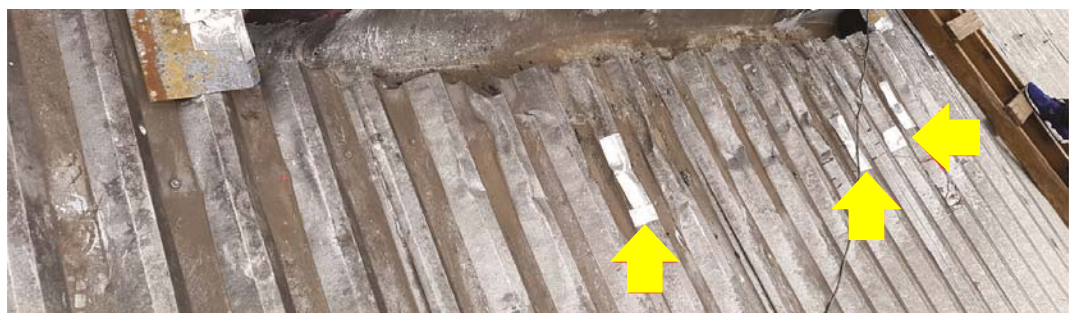
Pontos com reparos de manta asfáltica aluminizada autocolante
